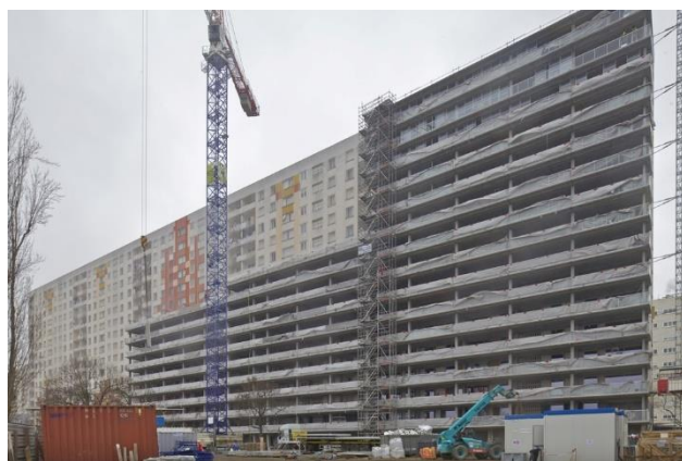
Bordeaux: Přístavba zimních zahrad na sídlišti Grand Parc
