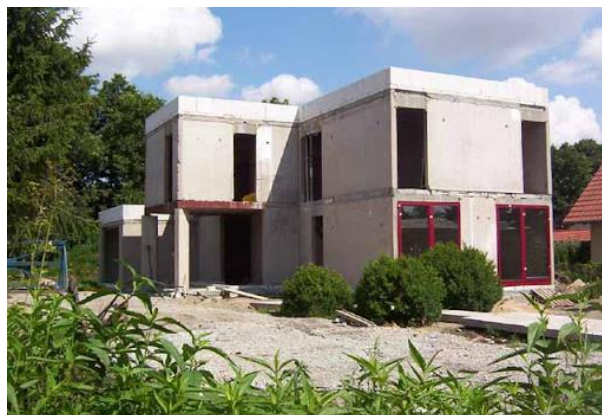
Mehrow: Hrubá stavba rodinného domu z recyklovaných panelů
