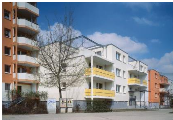
Berlín: Terasy na střeše sníženého panelového domu
