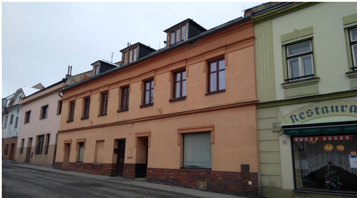
Obrázek 4 Bytový dům na adrese Halaškově náměstí 33, archiv výzkumníků
