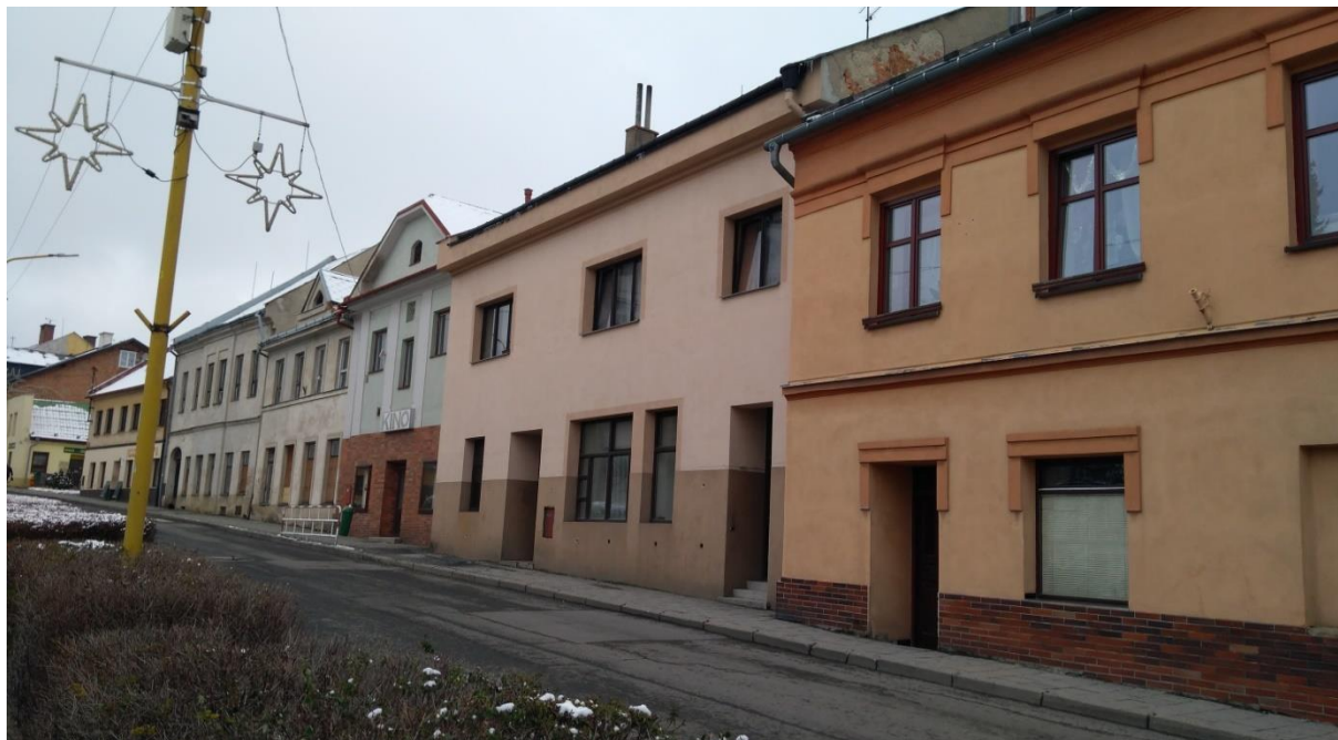
Obrázek 3 Bytový dům na adrese Halaškově náměstí 32, archiv výzkumníků
