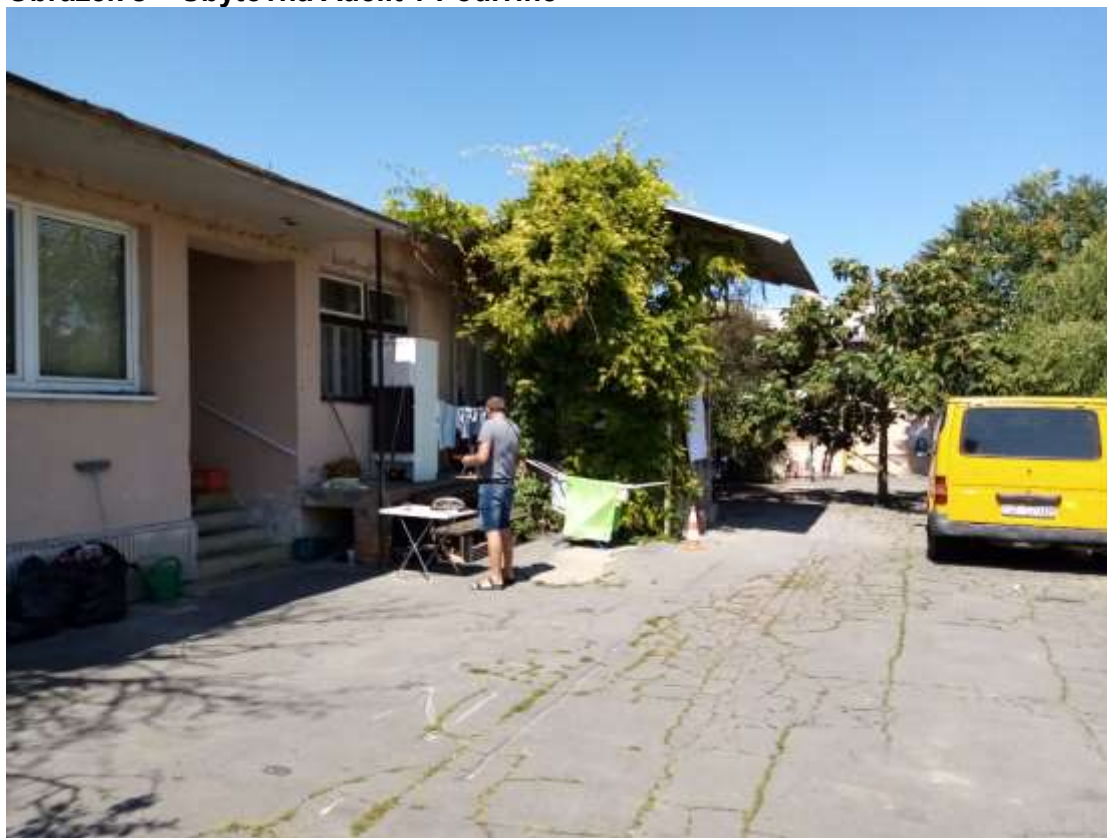
Obrázek 5 – Ubytovna Adelit v Podivíně
