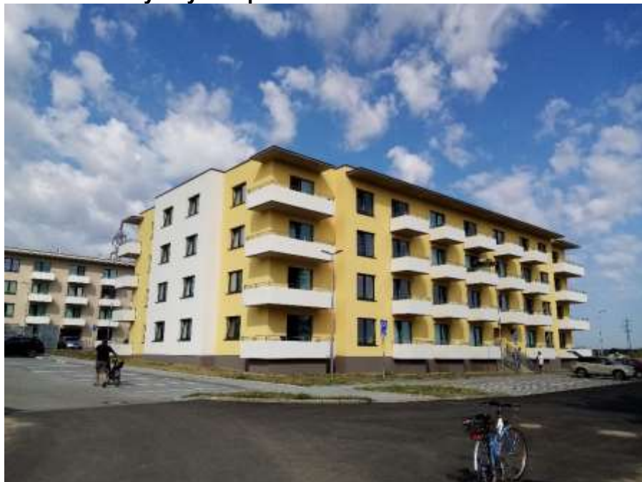
Obrázek 9 – Bytový komplex "Na Lukách" v Břeclavi
