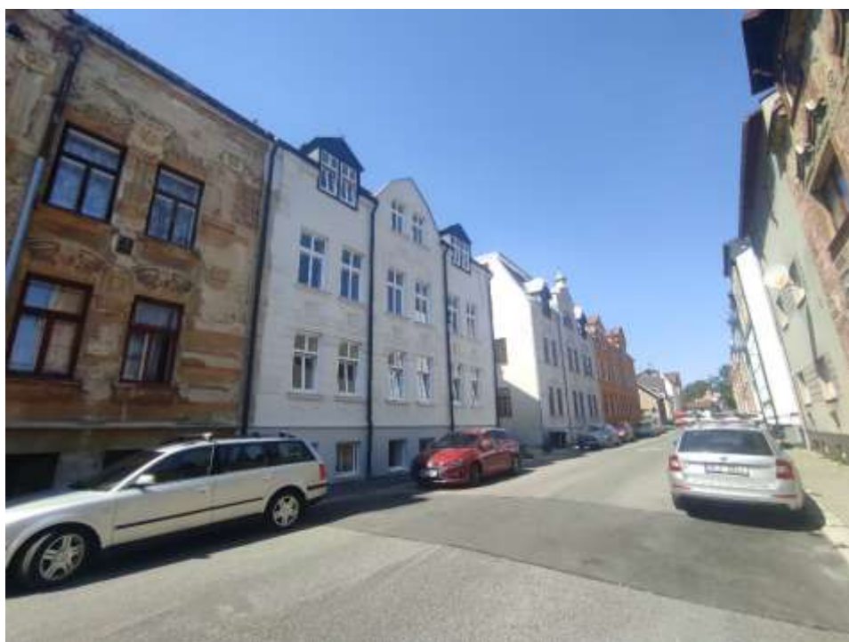
Obrázek 8 Saskova 27, zdroj: autor analytického podkladu (stav srpen 2023)
