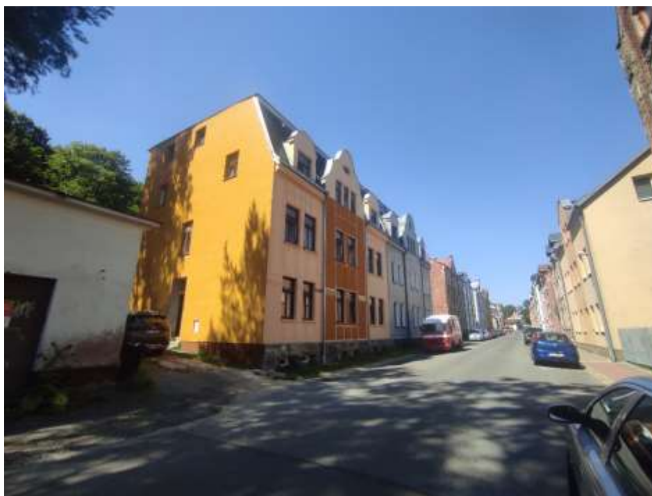
Obrázek 6 Saskova 21, zdroj: autor analytického podkladu (stav srpen 2023)
