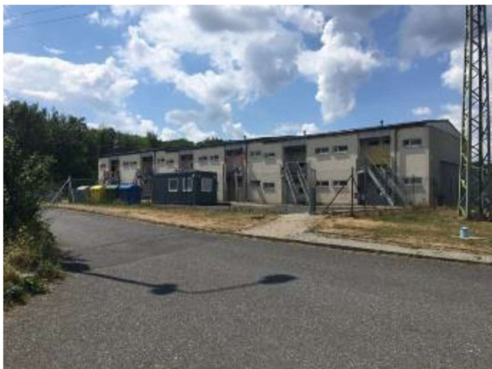
Obrázek 2: Zrekonstruovaný dům v Březenci, stav k červnu 2018
