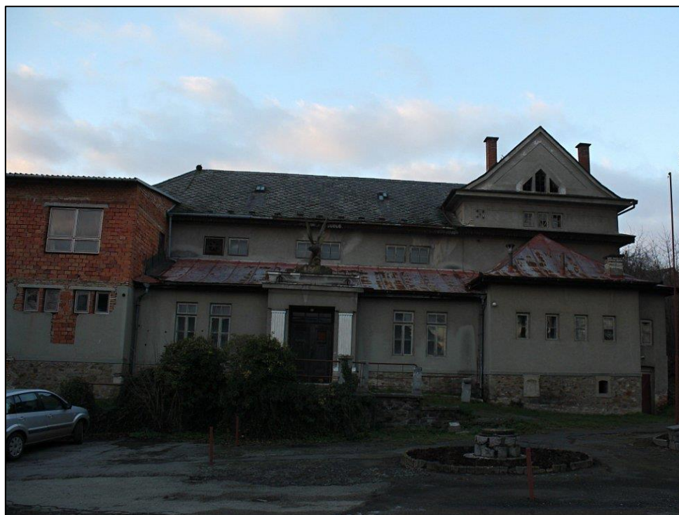
Obrázek č. 2: Budova Komunitního centra před renovací (rok 2014)
