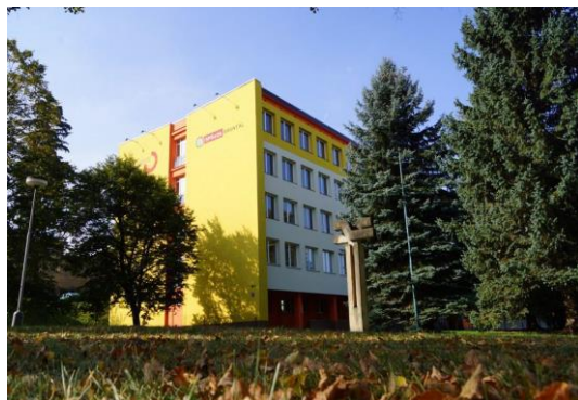
Obrázek 21 Budova SPŠ a OA v Bruntále
