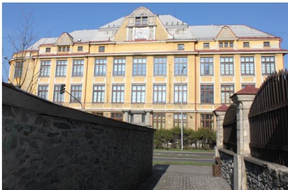
Obrázek 22 Budova Všeobecného a sportovního gymnázia, Bruntál, příspěvkové organizace
