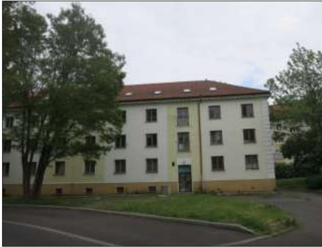
Fotografie č. 14: Blok 15 v Chomutovské ulici
