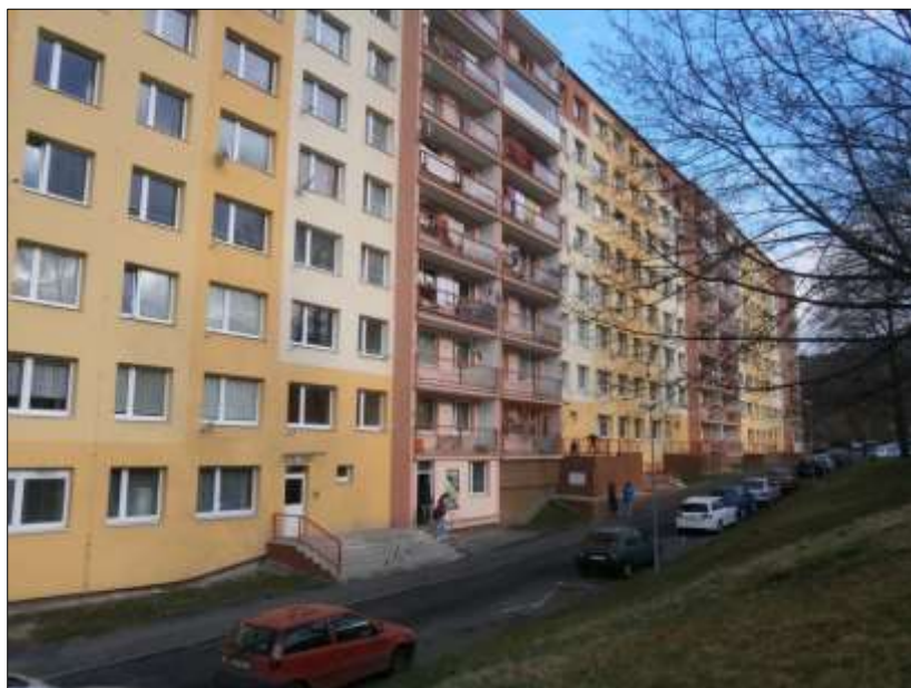
Fotografie č. 9: Panelový dům v ulici K. H. Borovského 19
