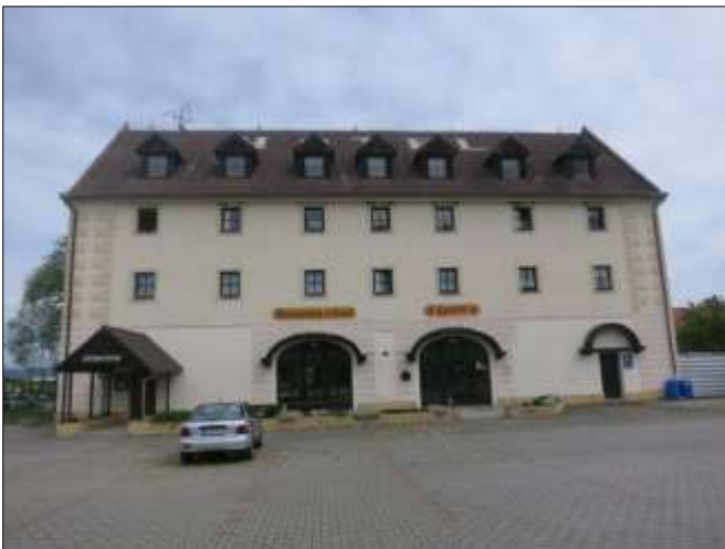
Fotografie č. 18: Ubytovna U Špejcharu
