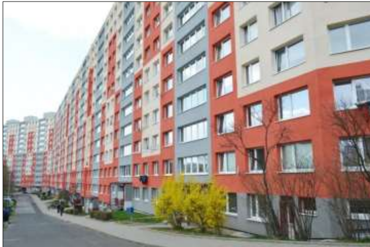
Fotografie č. 10: Panelový dům v ulici Javorová 21
