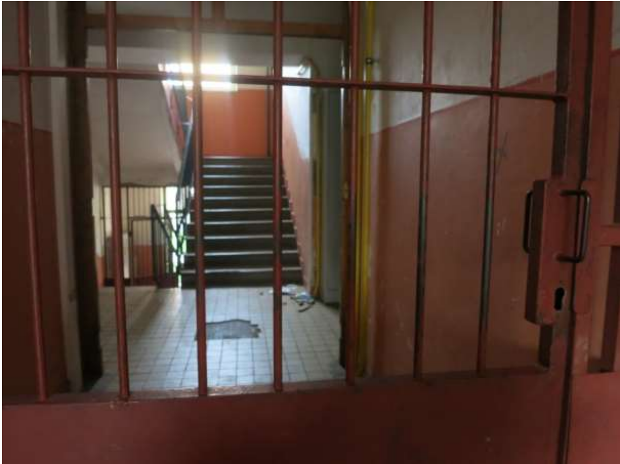
Fotografie č. 5: Chodba jednoho z vchodů bloku 93
