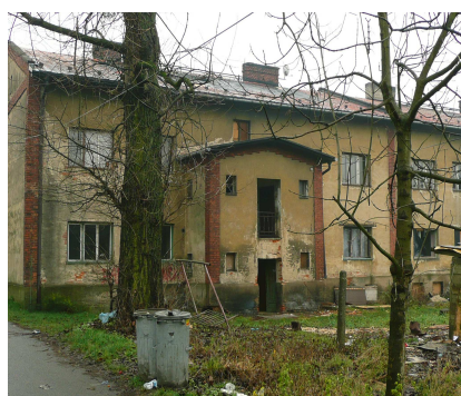
Dům na ulici Trnkovecká
