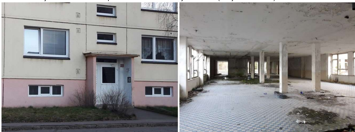
Foto č. 8 a 9: Bývalé sídlo NZDM Lampa a interiér zchátralé školy v Ploužnici (zdroj: archiv autora)
