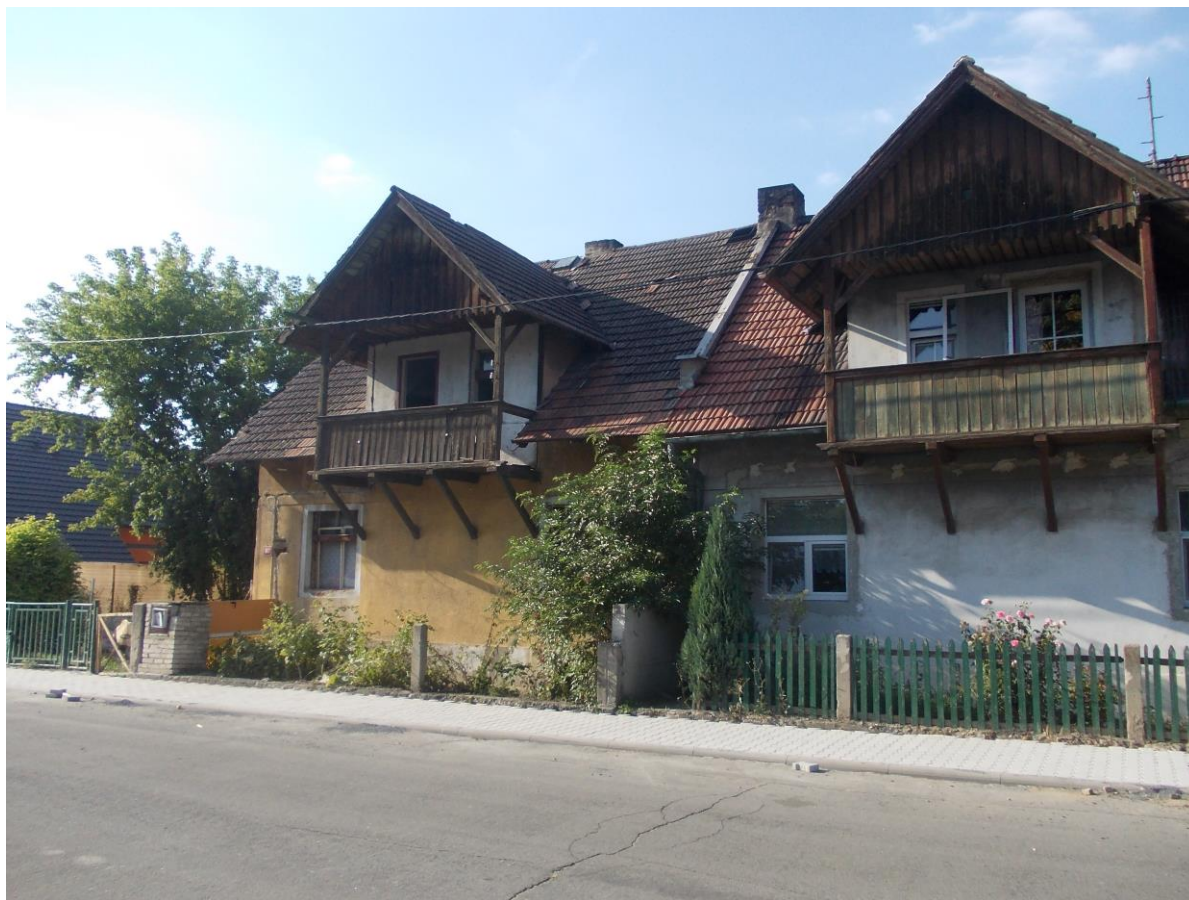
Obrázek 4: Dům na adrese Stračenská 347 (vlevo)
