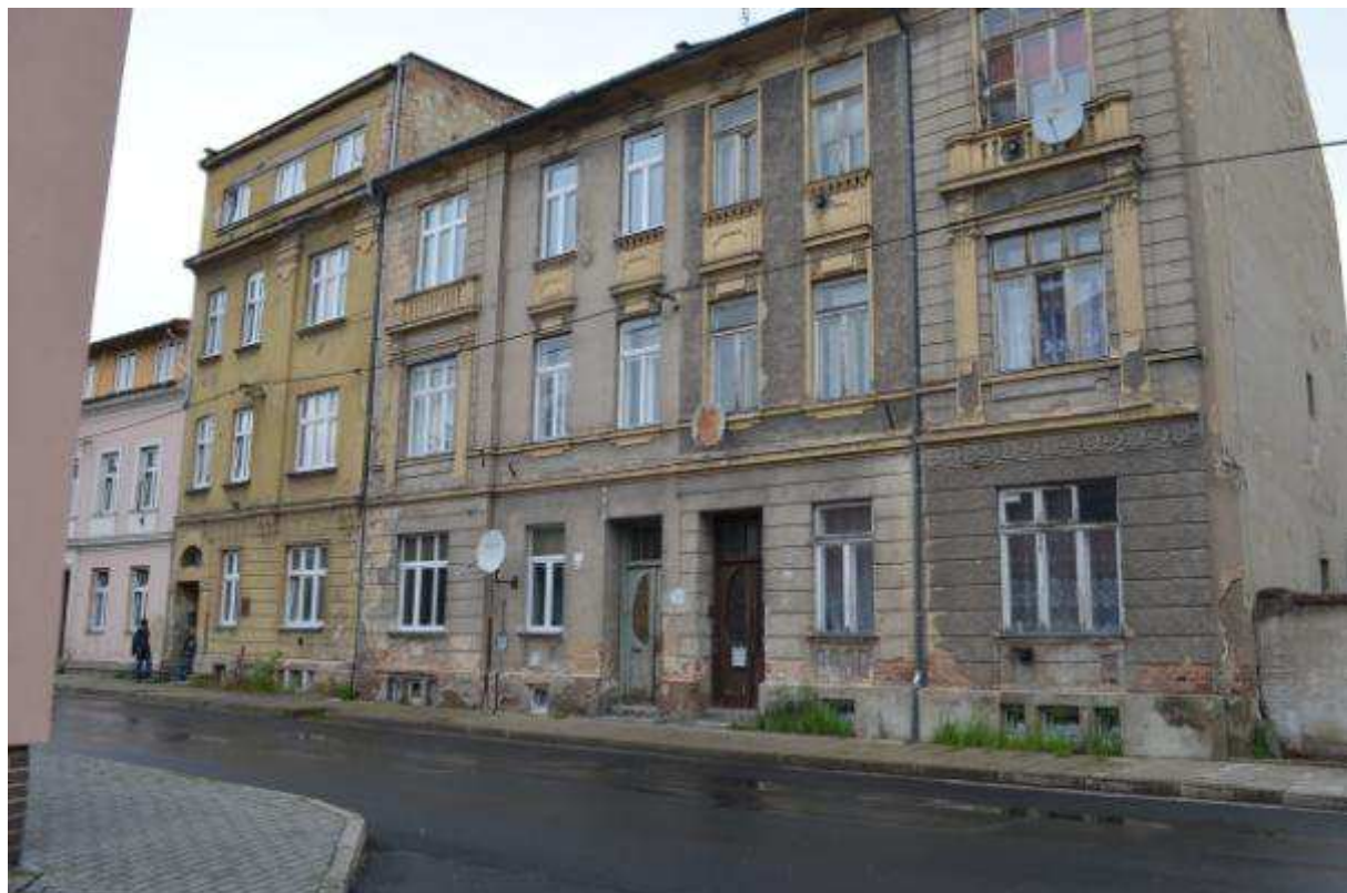
Foto 10: Dům U Požárníků 64/61 je druhý vchod zprava
