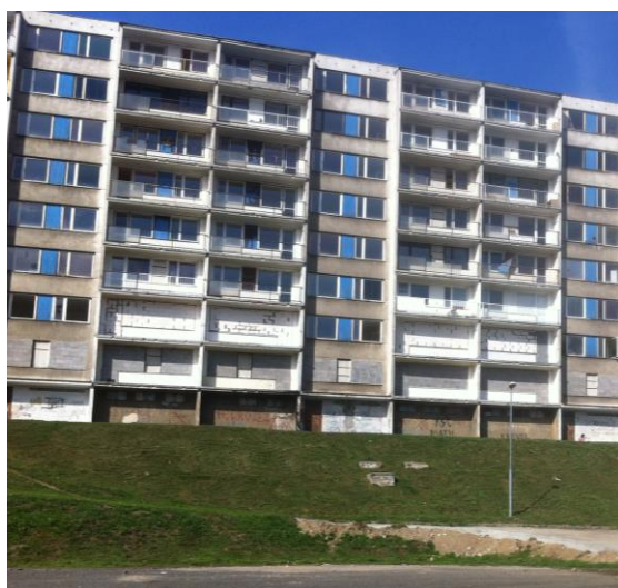
Obr. 2: Zazděné domy v Janově.
