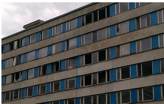
Obr. 3: Zazděné/opuštěné byty v Janově.
