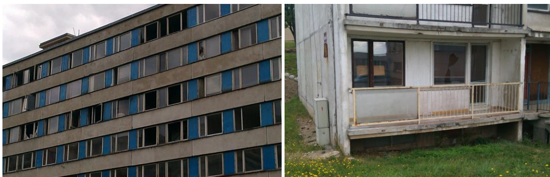
Obr. 3: Zazděné/opuštěné byty v Janově.
