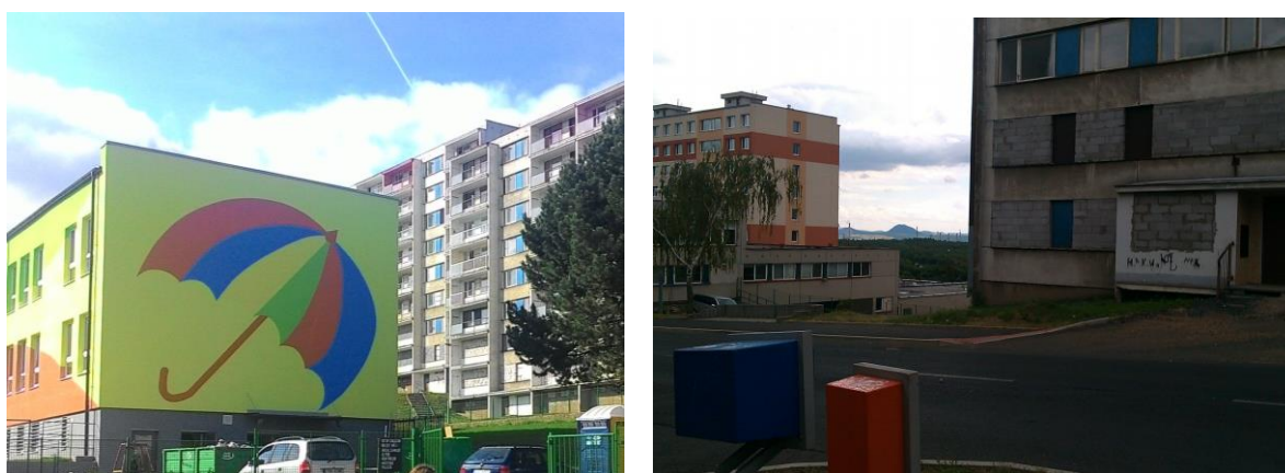
Obr. 25 a 26: Paralelní procesy rekonstrukce a rozpadu v Janově. Vlevo: Mateřská škola (v popředí) kontrastuje s panelovým domem, který je vystěhován a do výše 2. patra zazděný. Vpravo: zazděný dům, před kterým je nově opravený chodník. V pozadí nově rekonstruovaný dům. Zdroj: Archiv autorů
