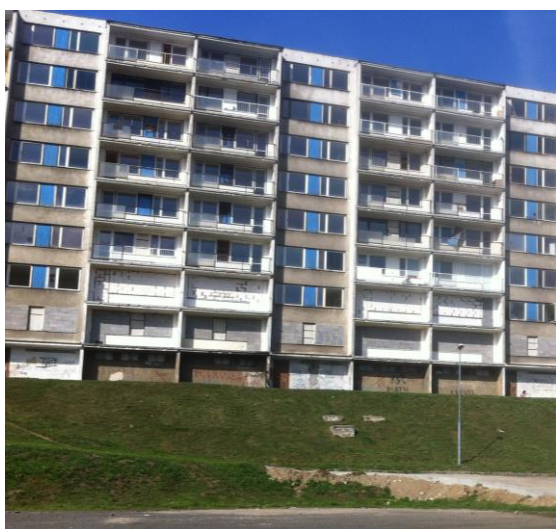
Obr. 2: Zazděné domy v Janově.
