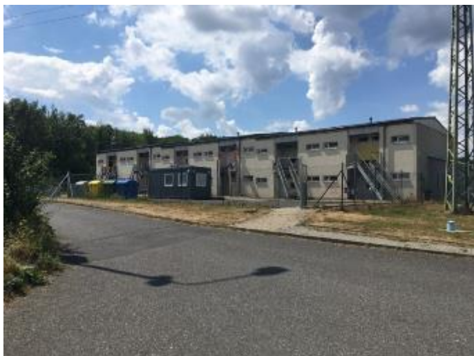
Fotografie 1: Zrekonstruovaný dům v Březenci, stav k červnu 2018
