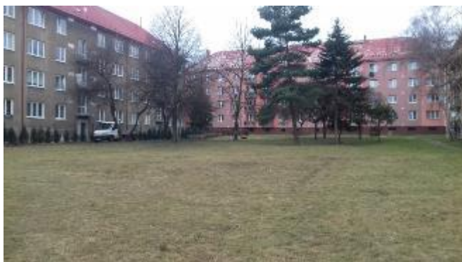
Fotografie 4: Sídliště Ervěnice, stav k červnu 2018
