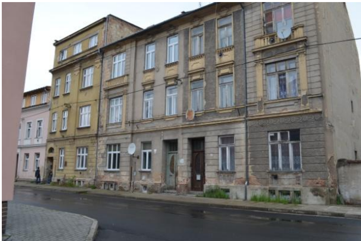
Foto 10: Dům U Požárníků 64/61 je druhý vchod zprava
