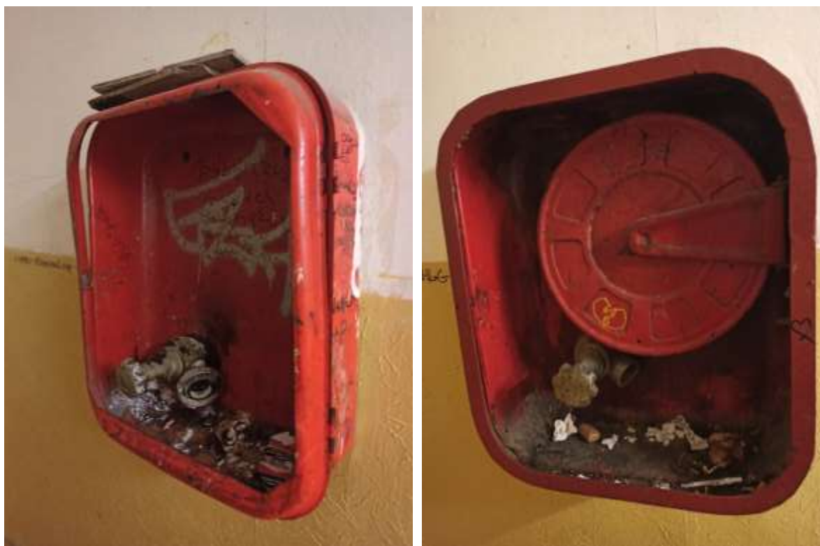
Obrázek 6 Hydrantové skříně bez hadic v č. p. 480, podzim 2021
