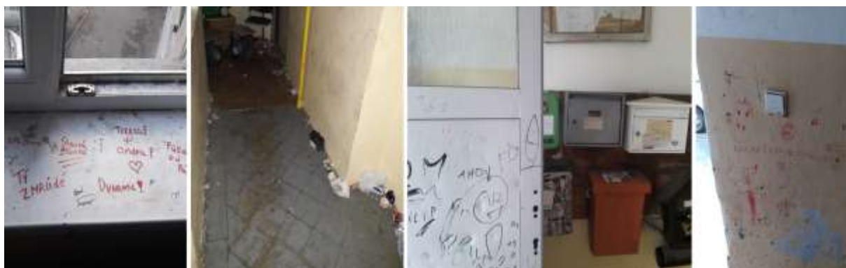
Obrázek 17 Interiéry chodeb (archiv autorů, podzim 2021)
