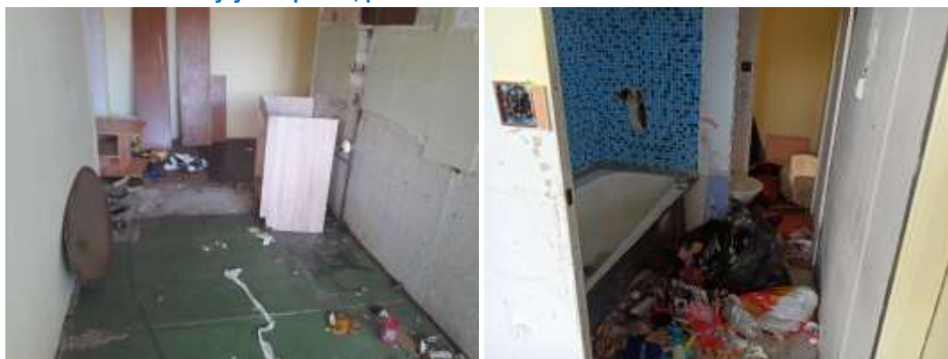
Obrázek 7 Zničené byty v č. p. 480, podzim 2021
