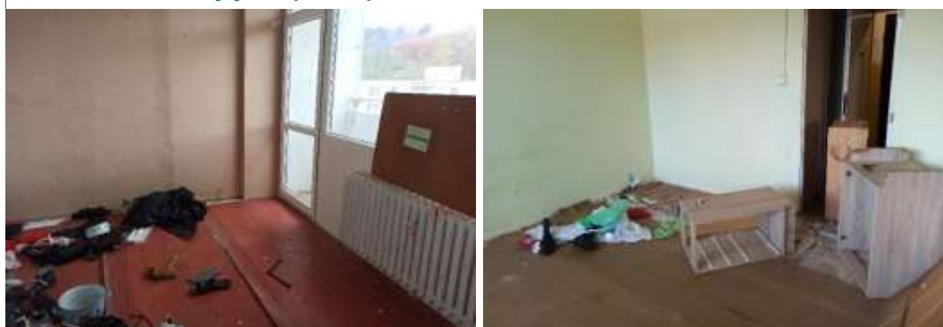
Obrázek 8 Zničené byty v č. p. 480, podzim 2021
