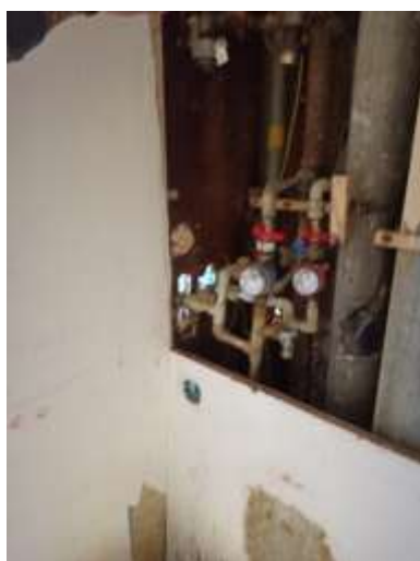
Obrázek 12 Nezabezpečené rozvody v prázdném bytě bez vstupních dveří v č. p. 480, podzim 2021
