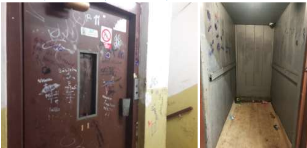
Obrázek 5 Výtah v č. p. 480 (výtahové dveře a výtahová kabina), podzim 2021
