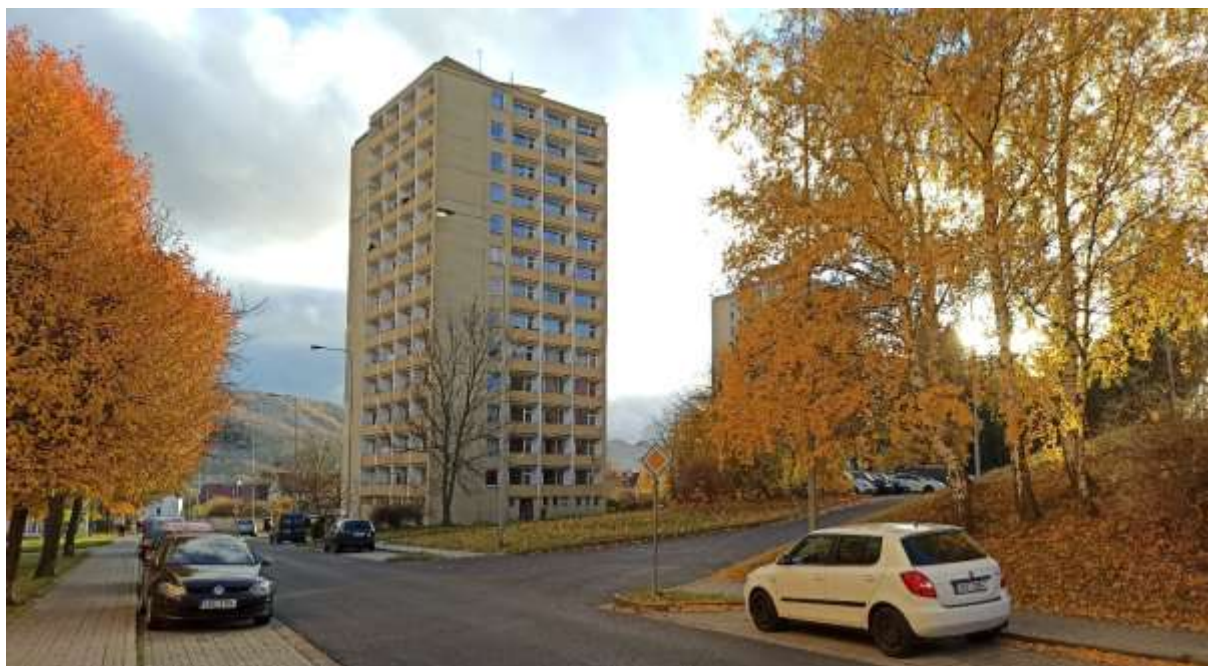
Obrázek 1 Bytový dům č. p. 480 v ulici Mírová, podzim 2021
