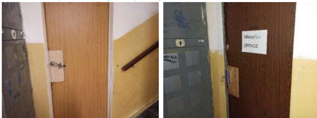
Obrázek 11 Vstupní dveře do bytů v č. p. 480, podzim 2021
