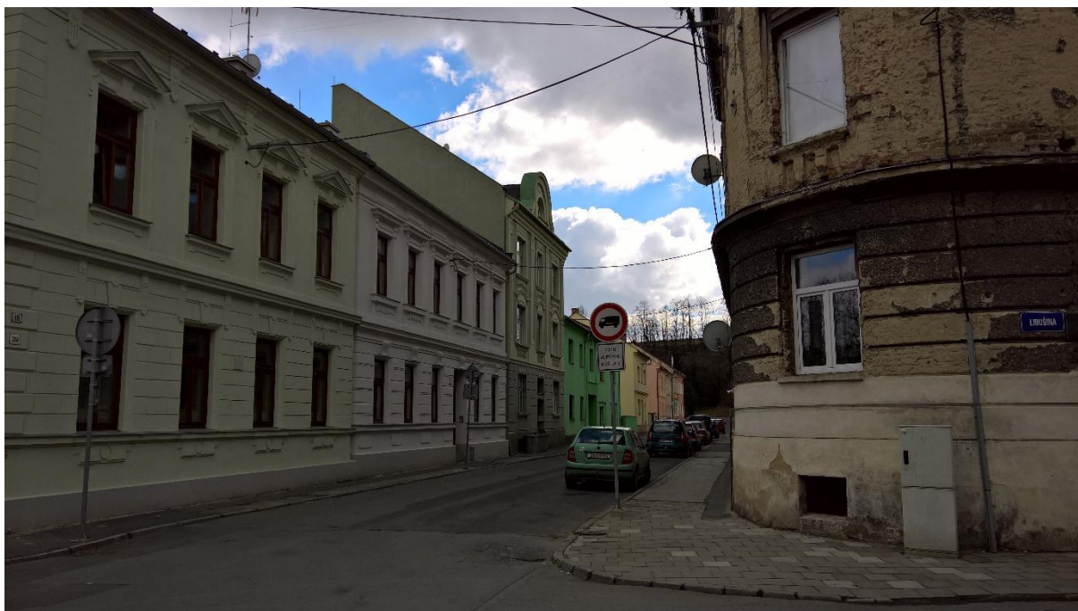
Obrázek 14 Opravené domy na adrese Stará č. p. 15 a č.p. 17
