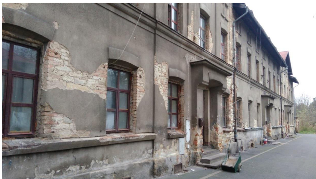
Fotografie č. 2: Městská ubytovna Mexiko – přední část budovy
