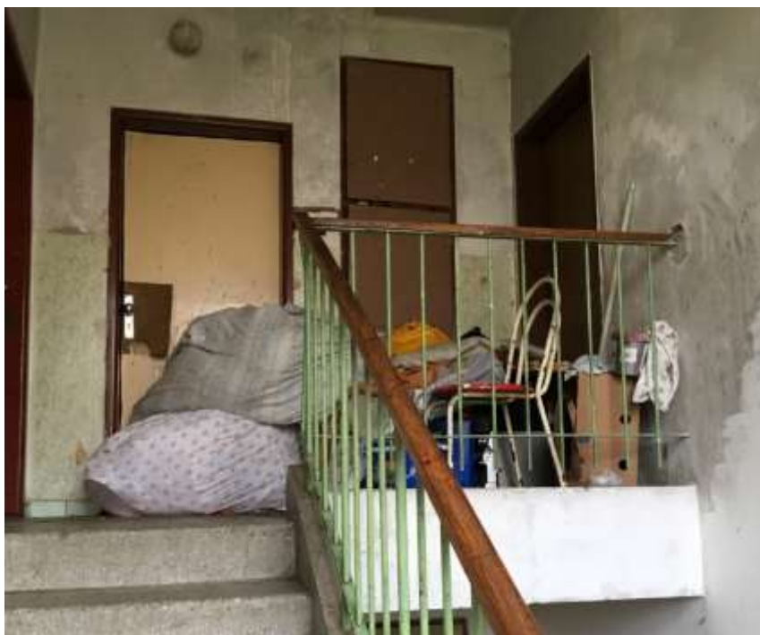
Fotografie č. 2: Stav na chodbách sociálně vyloučeného bytového domu (čp. 197,198), stav k říjnu 2017.
