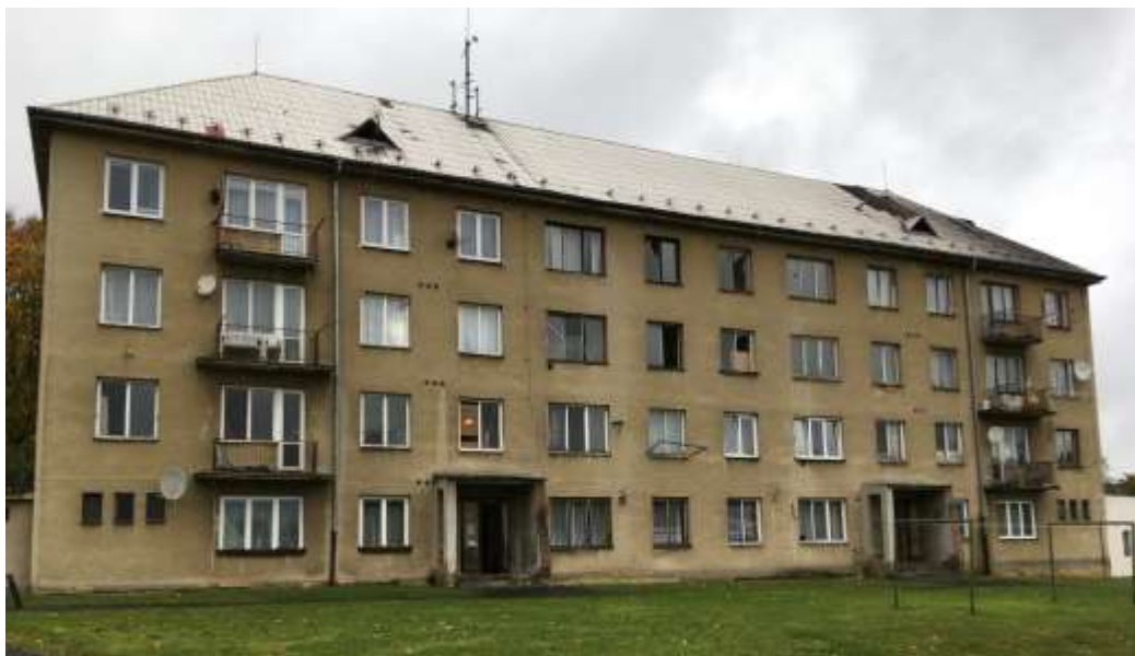
Fotografie č. 1: Sociálně vyloučený bytový dům (čp. 197,198), stav k říjnu 2017.
