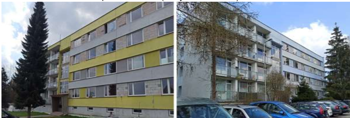
Foto 12 a 13: Hrnčířská č. p. 2725 a 2726 (zdroj: archiv autora)
