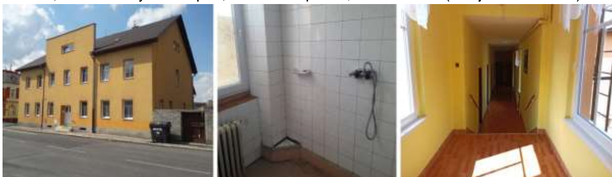
Foto 15, 16 a 17: Ubytovna Sport, Žitavská č. p. 886, stav 04/2021 (zdroj: archiv autora)
