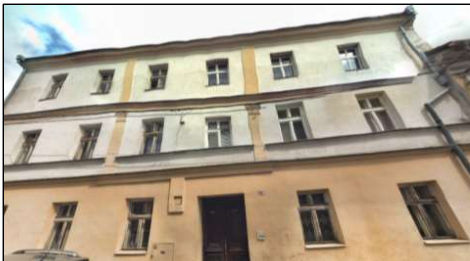
Obrázek 11 – bytový dům na ulici Palackého 307 (zdroj: mapy.cz)
