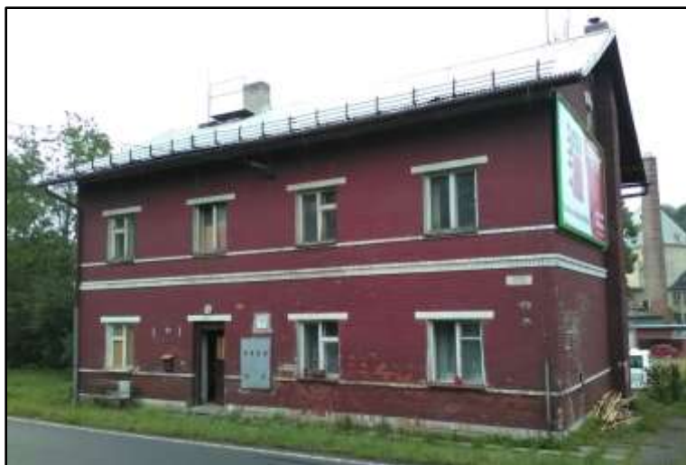
Obrázek 14 – bytový dům Jelení 126 (v majetku ČD)
