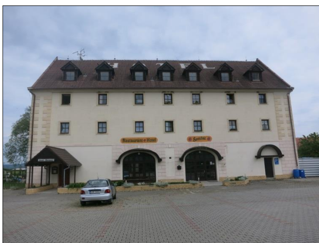
Fotografie č. 18: Ubytovna U Špejcharu
