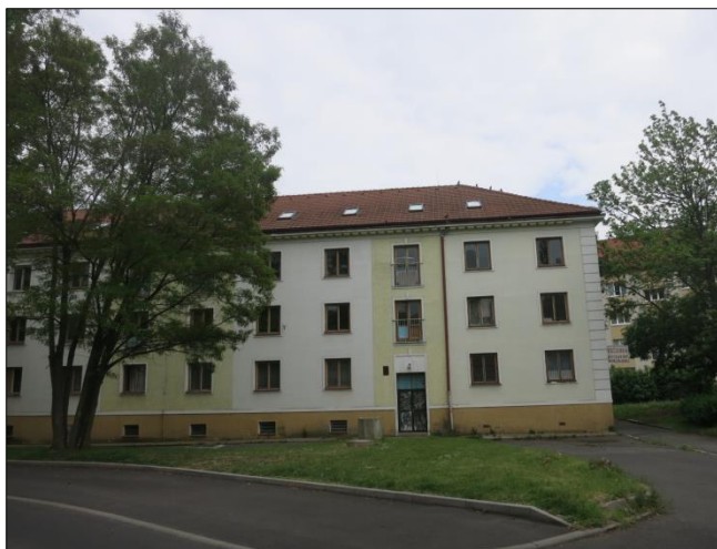
Fotografie č. 14: Blok 15 v Chomutovské ulici
