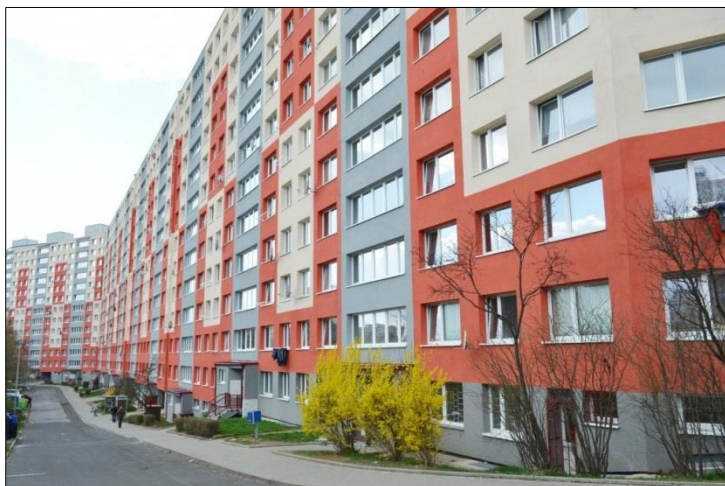
Fotografie č. 10: Panelový dům v ulici Javorová 44
