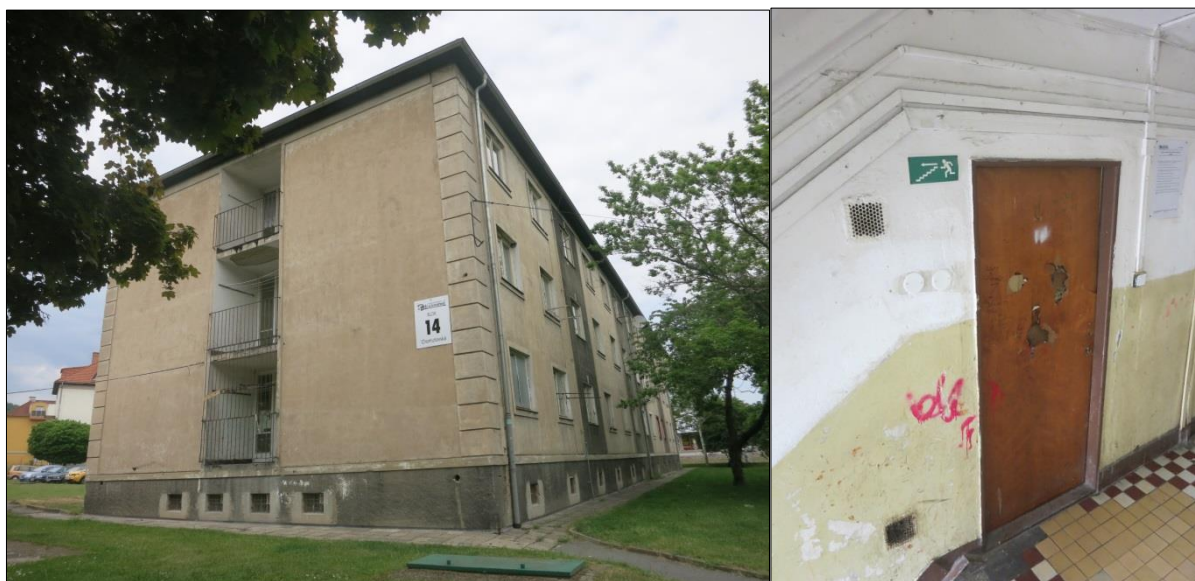
Fotografie č. 13: Blok 14 v Chomutovské ulici
