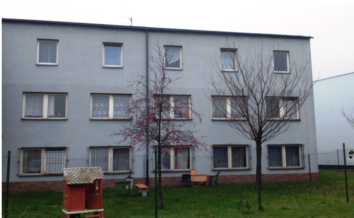
Fotografie č. 3: Městská ubytovna v Tovární ulici
