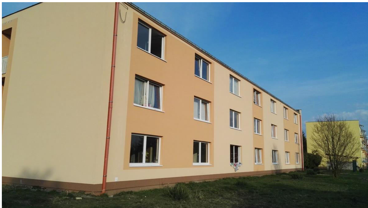
Fotografie č. 4: Ubytovna v Čankovicích
