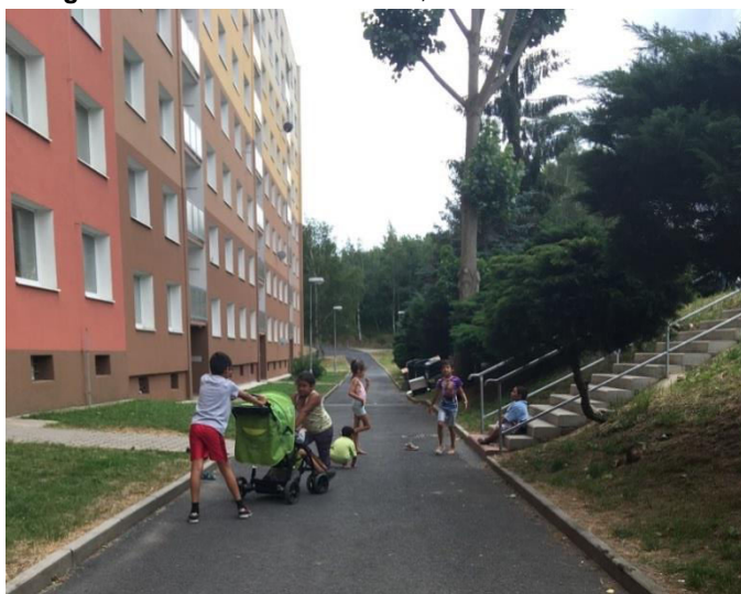
Fotografie č. 5: Sídliště Vinařice II., stav k červnu 2018
